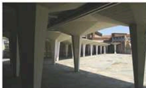
porticato che raccorda gli edifici pubblici
